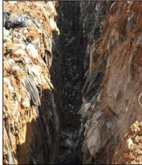
B – Canaletas no maciço das células de lixo para aliviar a pressão no talude.
