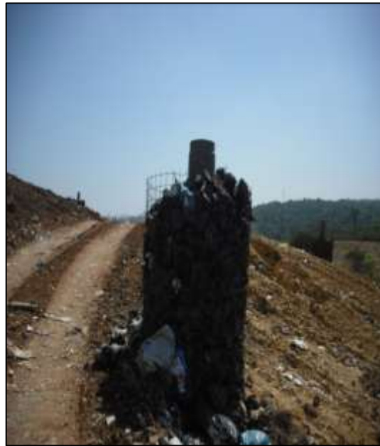
C – Dreno vertical de gás tipo Ranzini para aliviar a pressão de gás do talude.
