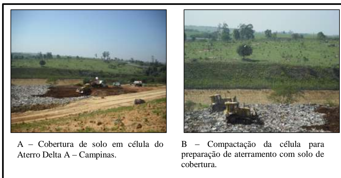
Fotos 6. 2 - Procedimentos de cobertura (A) e compactação (B) de resíduo sólido no Aterro Delta A para eliminação de vetores. Fotos: Lídia Maria Diniz Gurgel Santos em 23 de agosto de 2011.
