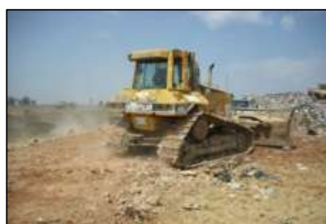
D – Compactação de célula de lixo no Aterro Delta A.
