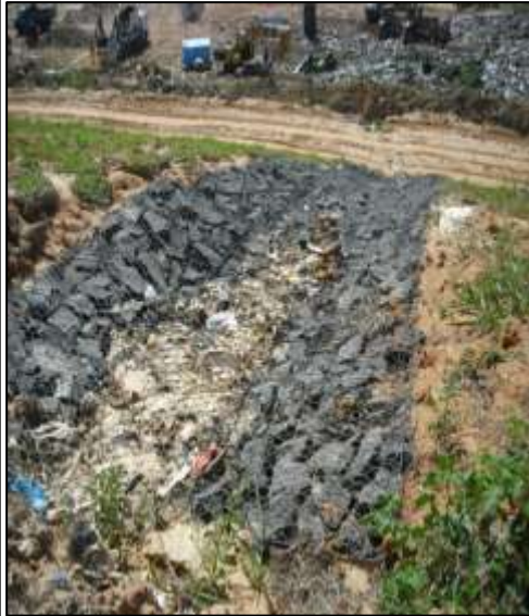
A - Colchão Reno para drenagem de águas superficiais no Aterro Delta A - Campinas
