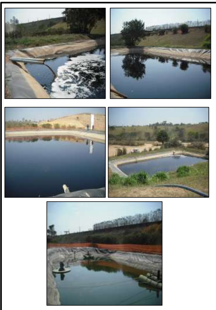
Fotos 6.1 – Lagoas de Captação de chorume no Aterro Sanitário Delta A, em região próxima a córrego das Cobras. Fotos: Lídia Maria Diniz Gurgel Santos em 27 de setembro de 2011.
