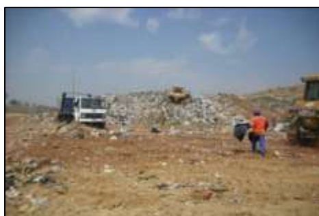
C- Frente de trabalho no Aterro Delta A.
