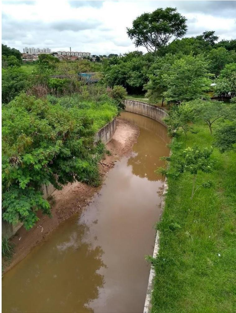
Foto 2. Deposição de sedimentos na parte convexa do canal canalizado. Impossibilidade da migração do Ribeirão. Foto: Alexandre Lippaus Rocha.
