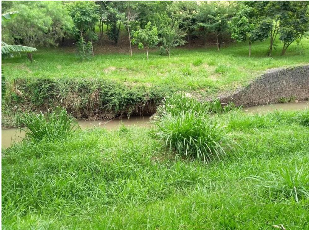
*Foto 5. Muro de Arrimo cedendo ao processo erosivo.*
