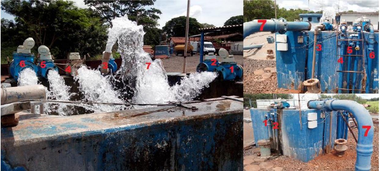
*Figura 10 - Fotos do tanque misturador das águas, em que os números não tem relação com os números de identificação dos poços, apenas números de controle utilizados na ETA para acompanhar os seis poços do Bauru (1-6) e o poço do Guarani (7).*
