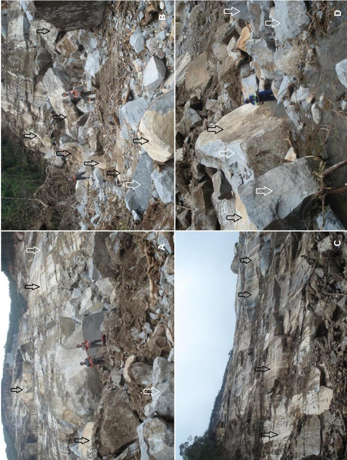
Figura 7.8: Evidência de intemperismo químico no interior do maciço devido à penetração de água em zonas de fraqueza (fraturas). As setas de cor preta indicam as faces que apresentam capa de intemperismo; as setas de cor branca apontam as faces ainda sãs ou com capa de intemperismo pouco desenvolvida. Fonte: Fotos cedidas pela SABESP e tiradas em 22/11/2011.
