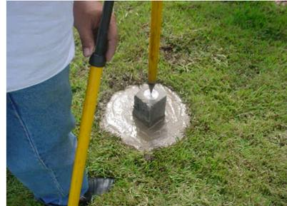
FIGURA 3 e FIGURA 4 – Implantação dos Marcos Base para Georreferenciamento
