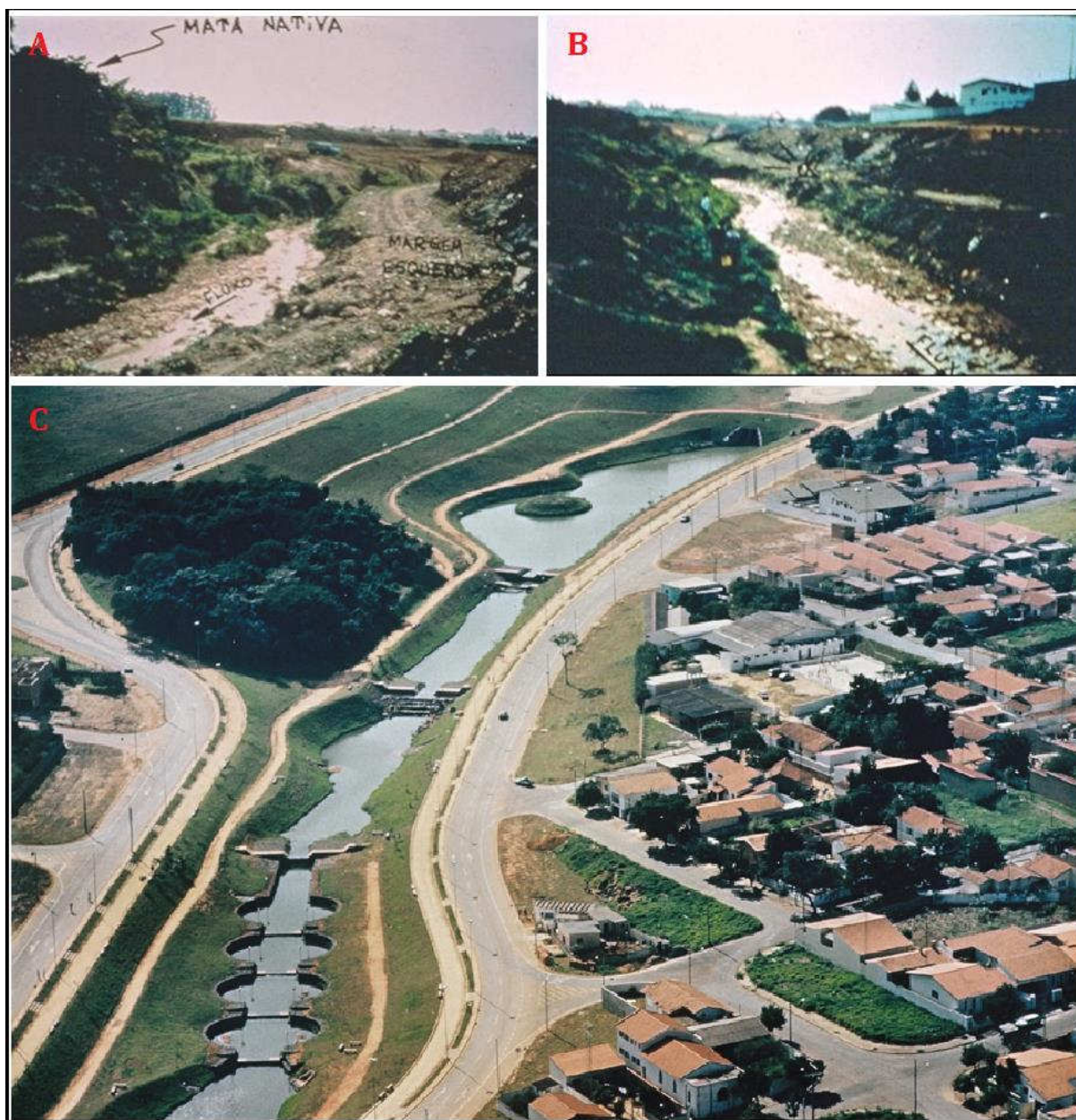
Figura 33. Córrego Barnabé antes e depois da implantação do parque
