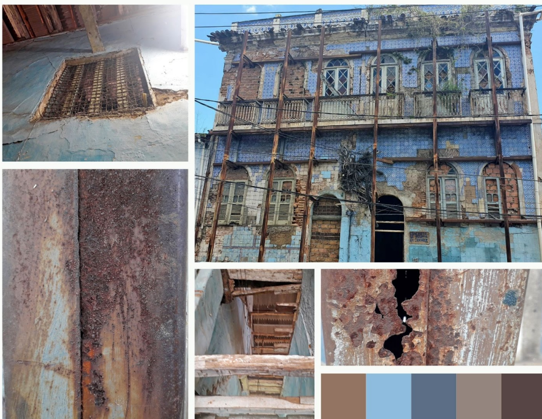
Fig. 30. Prancha 12 - Estruturas. Registro fotográfico.
