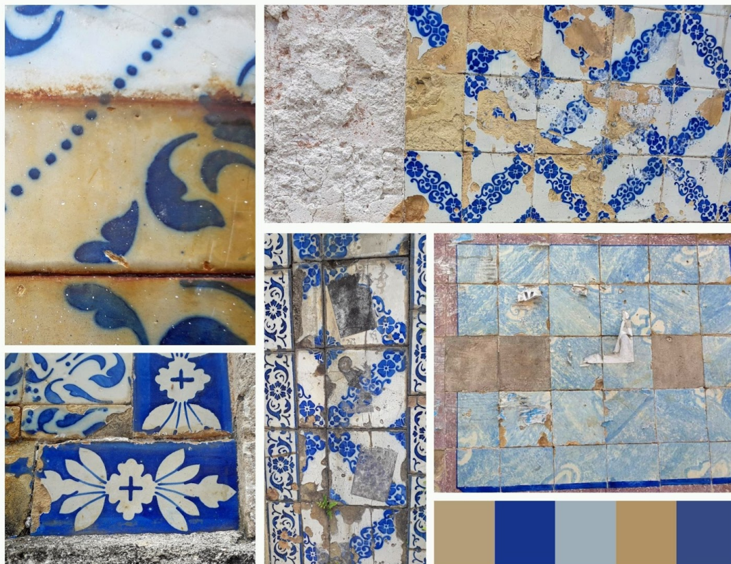
Fig. 28. Prancha 10 - Azulejos. Registro fotográfico.
