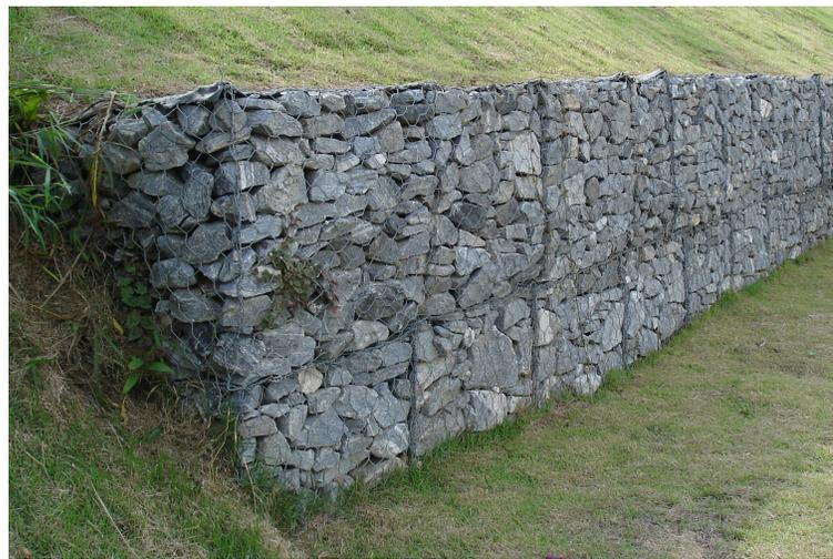
Figura 1.1: Exemplo de um muro gabião. Fonte: Eurico Zimbres - Licenciado sob CC BY-SA 2.5 - disponível no repositório da *Wikimedia Commons*.<sup>1</sup>
