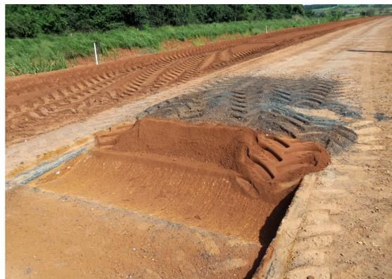
Figura 3 – Materiais extraídos do pavimento.
