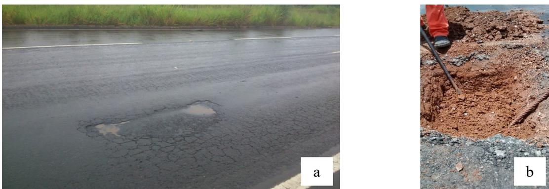
Figura 4.1 - Base com excesso de umidade em decorrência da infiltração de águas através da capa asfáltica
