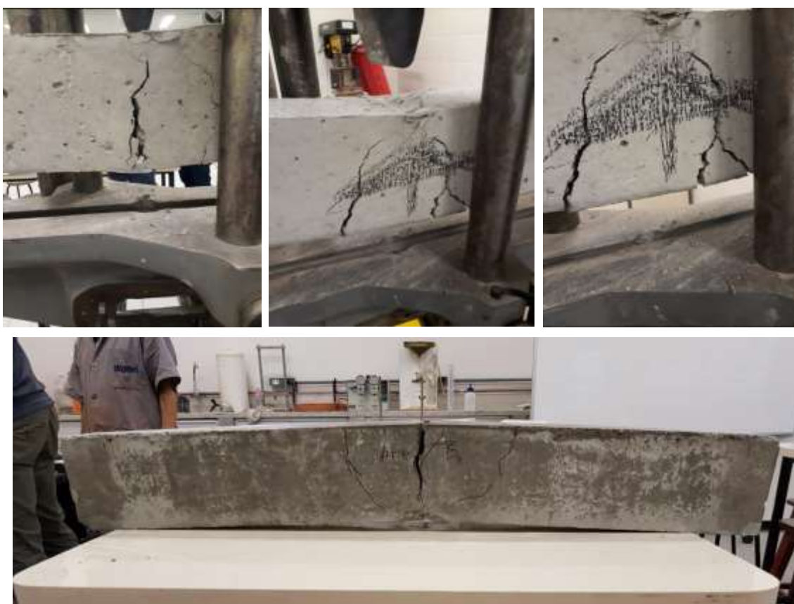
Figura 31 – Ruptura das vigas à flexão Fonte: O Autor (2021).
