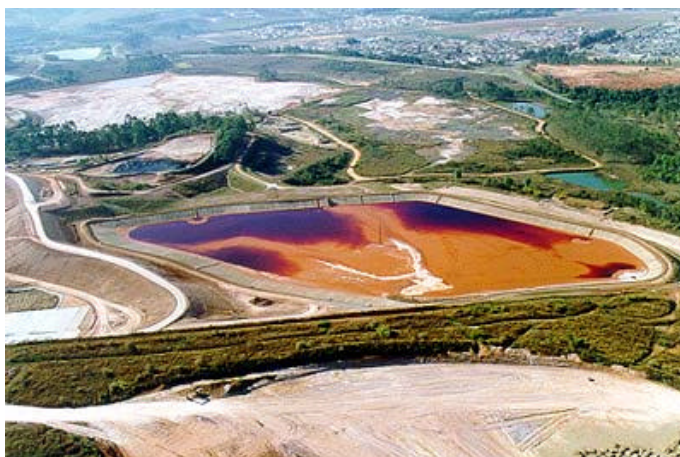
Figura 3: Lago de rejeito da Alcoa Alumínio S/A - Poços de Caldas / MG.
