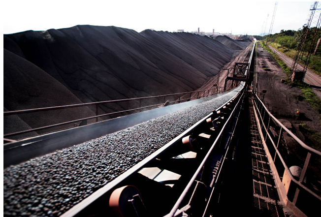
Figura 3.6: Esteira transportadora de Carvão Mineral
