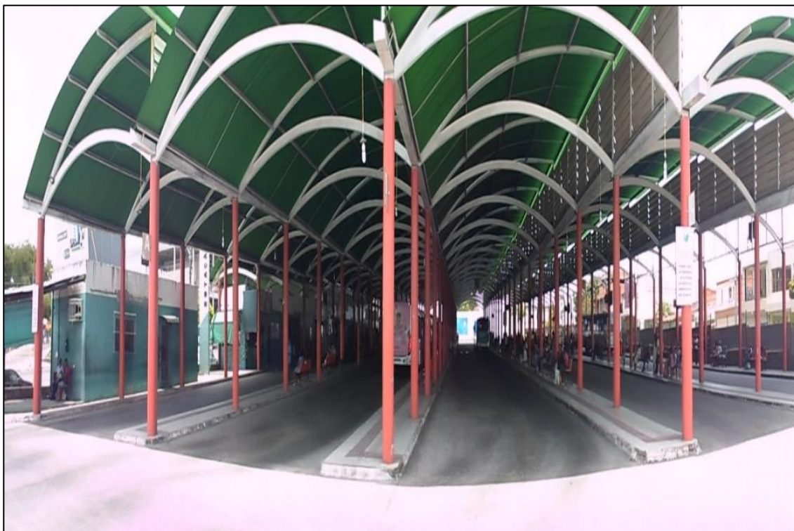
Foto 10: Vista interna do Transbordo Central de Feira de Santana
