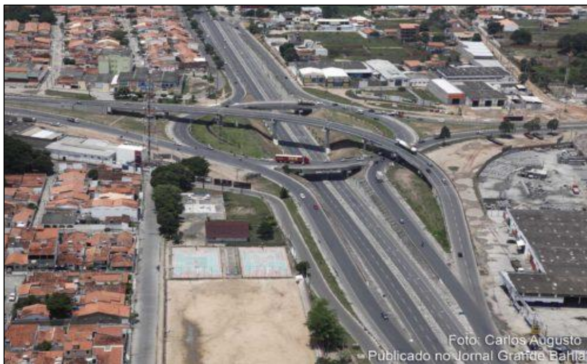
Foto 11: Complexo de viadutos em Feira de Santana que interliga as Avenidas Eduardo Froes da Mota e José Falcão da Silva com a BR 116 Norte
