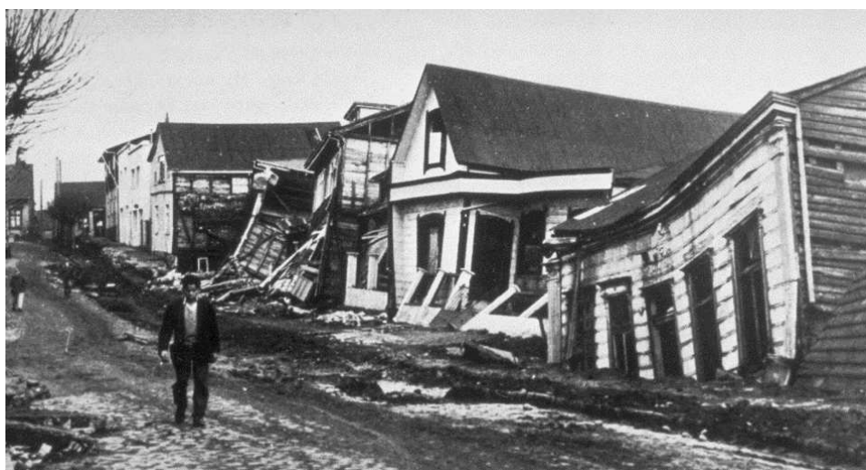
Figura 5. 6. “Dano produzido por um terremoto nas casas de madeira de boa qualidade em Valdivia, no Chile, em 1960. Fonte: NGDC Natural Hazards Slides with Captions Header. Autor: Pierre St. Amand. Retirado de: https://pt.wikipedia.org/wiki/Ficheiro:Valdivia_after_earthquake,_1960.jpg
