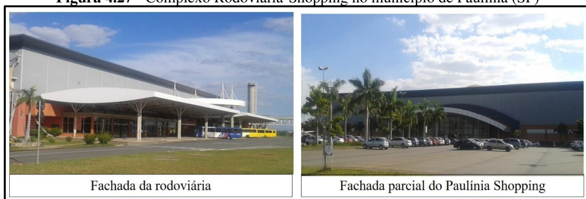
Figura 4.27 - Complexo Rodoviária-Shopping no município de Paulínia (SP)
