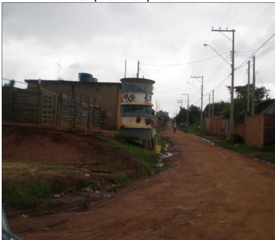
Foto 03 – Equipamento precário de abastecimento de água na região do Jardim Campo Belo em Campinas-SP
