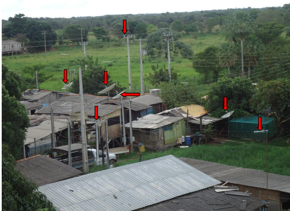
Figura 2.2: Casas de um vilarejo ribeirinho pantaneiro com rede de energia elétrica, antenas parabólicas e para telefonia celular (2012).
