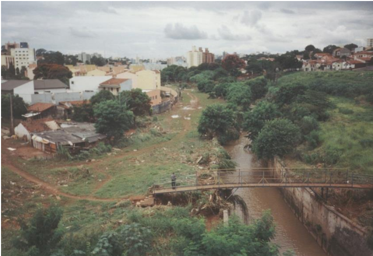
Área atingida pela enchente de 17/02/2003 próxima à confluência do ribeirão das Anhumas com o córrego Brandina. Data:18/02/03
