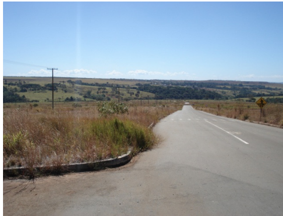
Foto 11 – Asfaltamento e vista da área da PLMG
