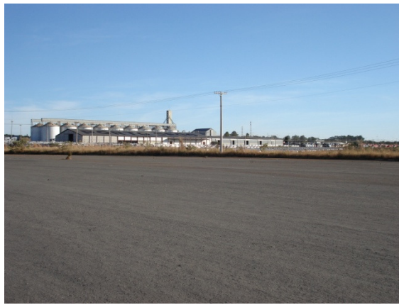
Foto 13 – Porto Seco visto da futura entrada da PLMG
