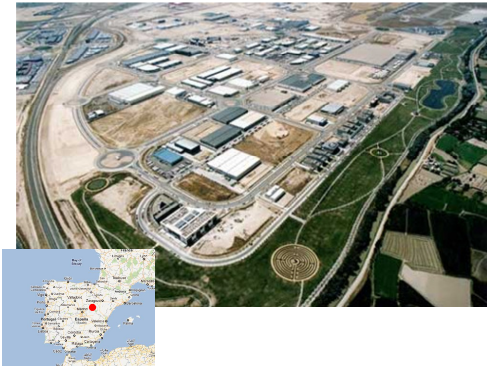
Figura 22 – PLAZA – Plataforma Logística de Zaragoza
