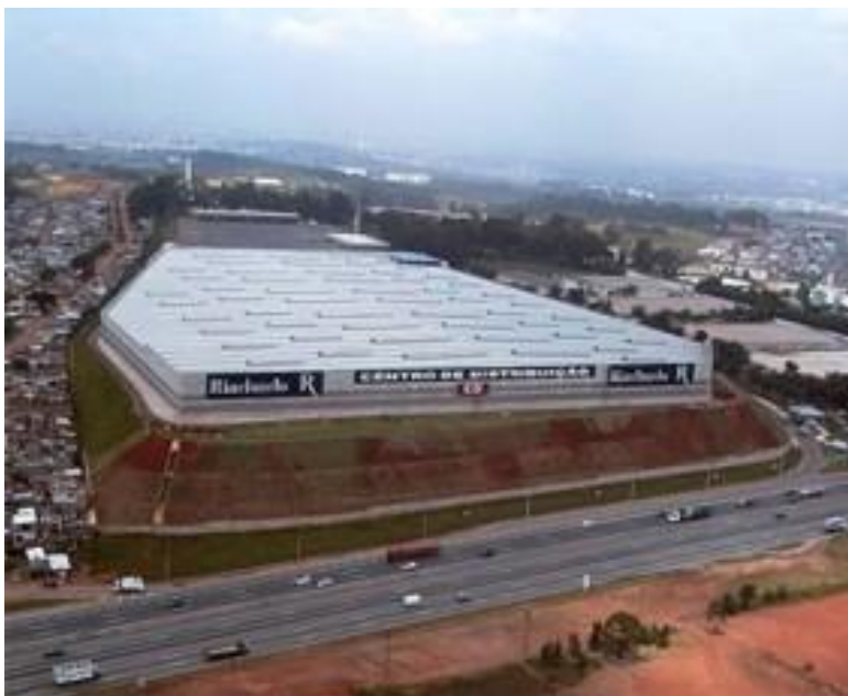
FOTO 3.21: VISTA AÉREA DO CENTRO DE DISTRIBUIÇÃO DA RIACHUELO EM GUARULHOS/SP
