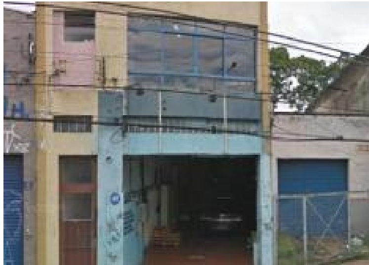
FOTO 3.13: IMÓVEL ONDE FUNCIONAVA OFICINA DE COSTURA SUBCONTRATADA POR INTERMEDIÁRIA DA ZARA NO CENTRO DE SÃO PAULO - 2011
