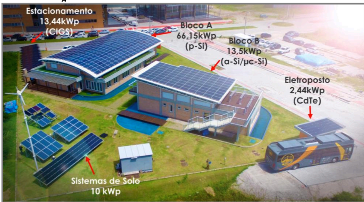
Figura 4.7 Sistema Fotovoltaico Laboratório Fotovoltaica UFSC
