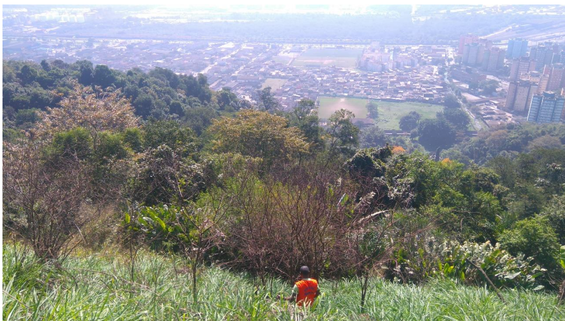
Figura 12.40 – Encosta íngreme onde foi escavada a Tr2
