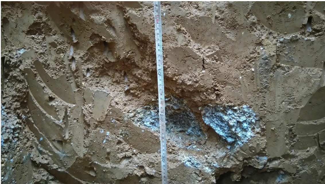
Figura 12.67 – Bloco intemperizado no perfil de solo da Tr9
