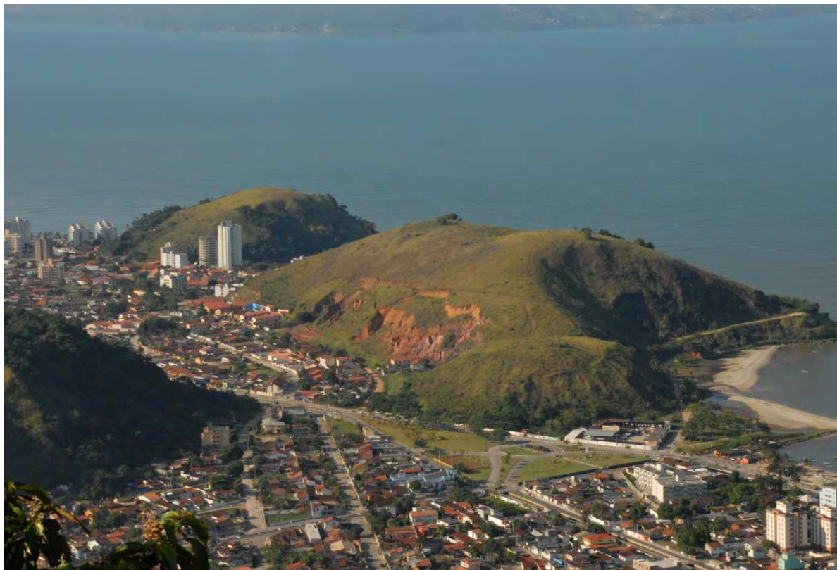
Figura 5.5.1 – Morro isolado na planície apresentando escorregamento no formato de rastejo (Foto: Francisco Ladeira)
