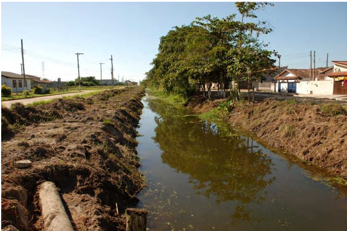
Figura 6.2.8 – Vala de drenagem na Bacia do Rio Juqueriquerê. (Foto: Francisco Ladeira)
