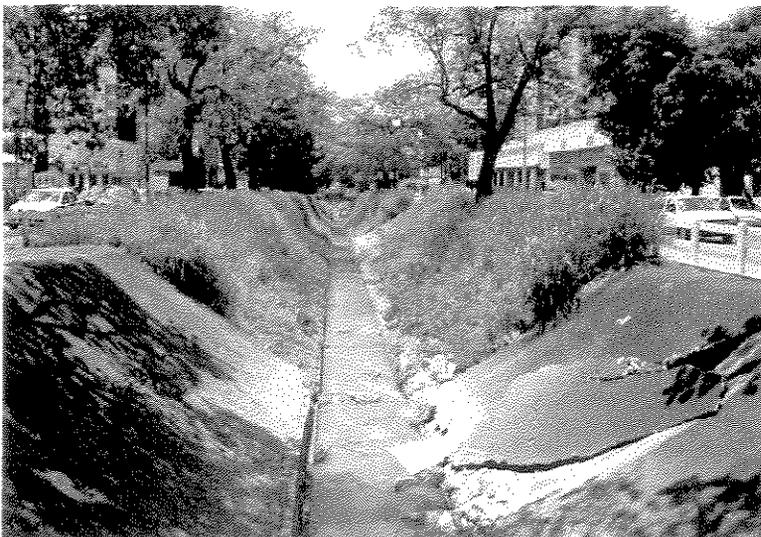
*Foto 3.* Desmoronamento da margem impermeabilizada do cor. Orosimbo Maia (enchente de 17/02/2003). Data 18/02/2003.
