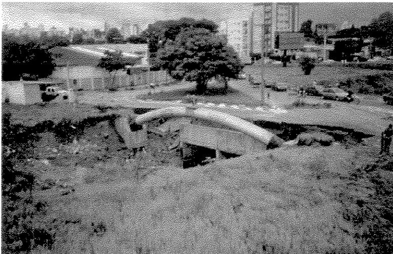
**Foto 6.** Erosão provocada pela enchente do dia 17/02/2003 no início do ribeirão Anhumas (Via Norte/Sul). Data 18/02/2003.
