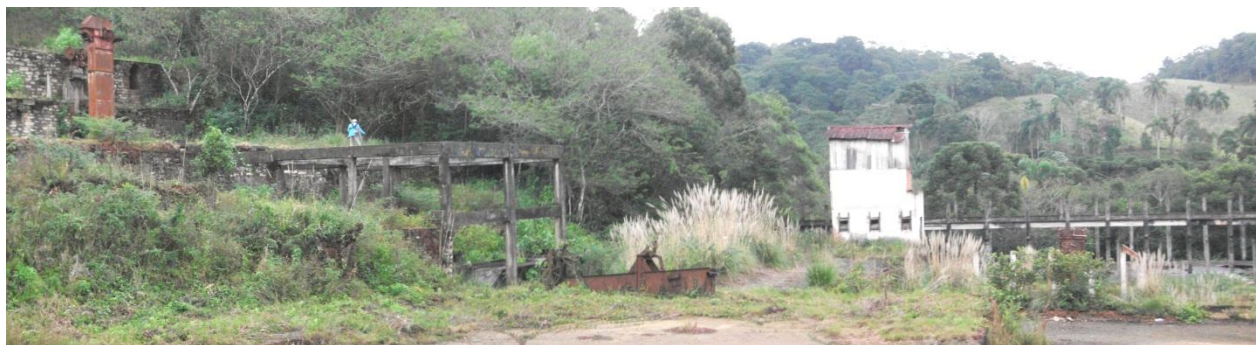
Figura A.1: Mapa da região sul do estado de São Paulo – município de Apiaí, hachurado (acima esquerda), casa do CIEM/CPRM (acima direita) e ruínas da antiga usina de beneficiamento (abaixo).
