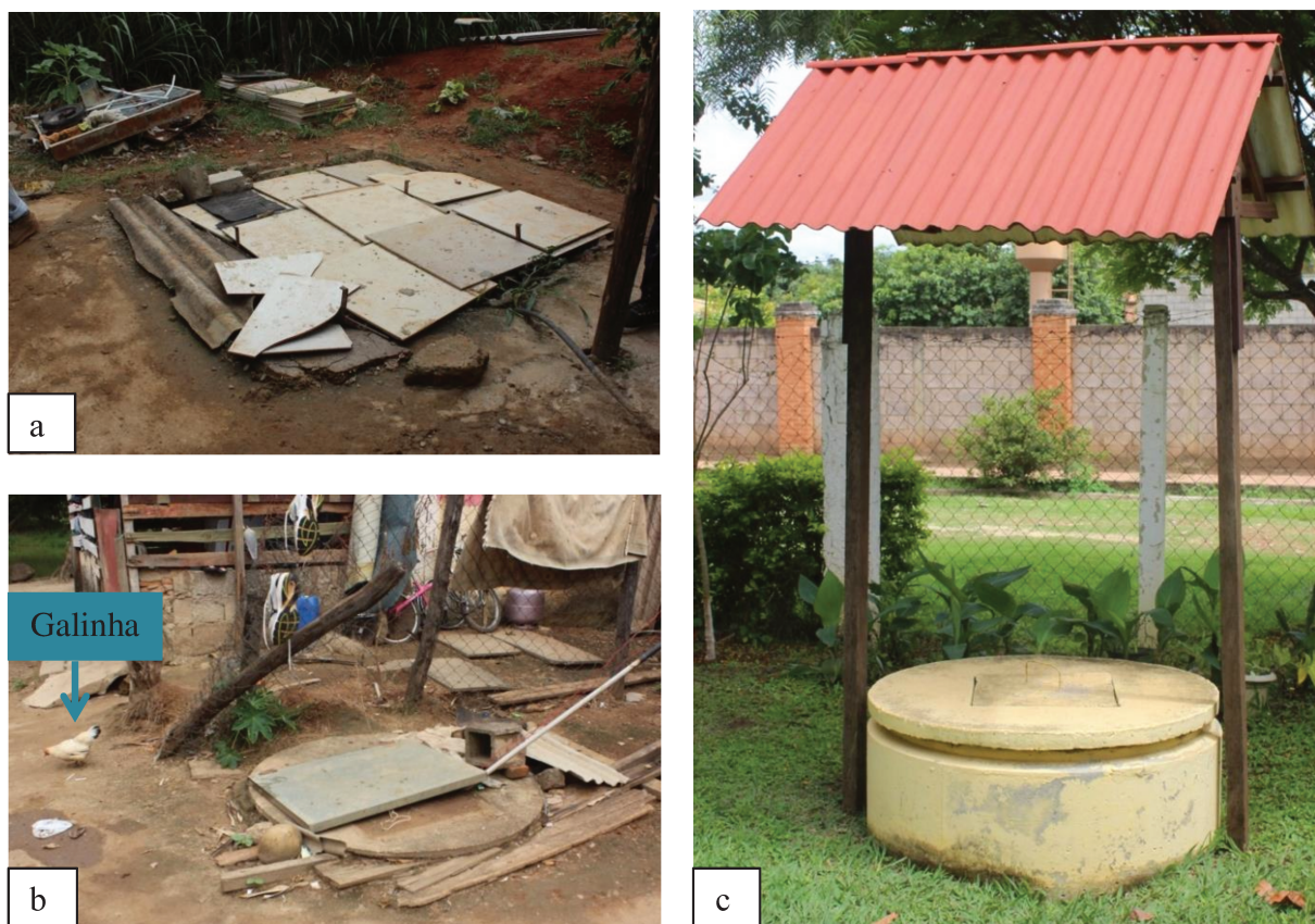
Figura 4.2: Características construtivas dos poços; a) poço de péssima qualidade com cobertura improvisada de mosaico, b) poço de péssima qualidade com cobertura improvisada de concreto e diversos acessórios, c) poço de boa qualidade com uma cobertura externa e o entorno devidamente limpo.
