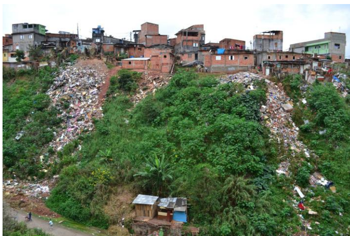
Figura 6.1: Lixo e Entulho Descartados por Moradores em Área com Risco de Escorregamento Planar no Parque Vila Santa Madalena, Subprefeitura da Vila Prudente – São Paulo, SP
