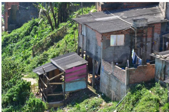
Figura 1.1 - Moradias precárias construídas em encosta inclinada na RMSP Fonte: autora, 2011
