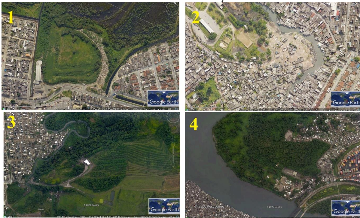
Figura 79- Pontos muito críticos com níveis muito alto de degradação em lugares onde se fazia ou se faz acondicionamento e destinação de resíduos sólidos.
