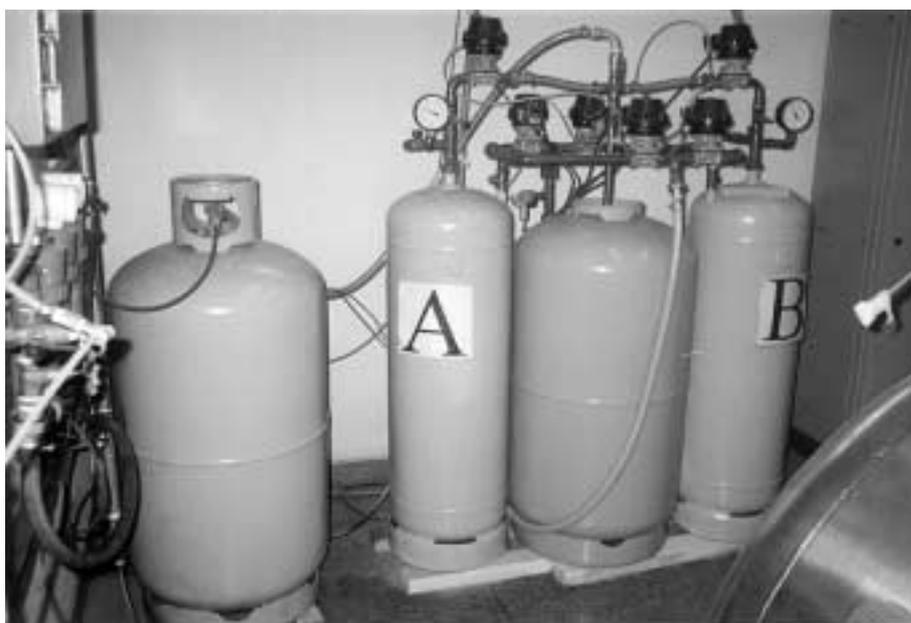
*Figura AI.1 – Fotografia do sistema PSA construído na Central de Criogenia - IFGW.*
