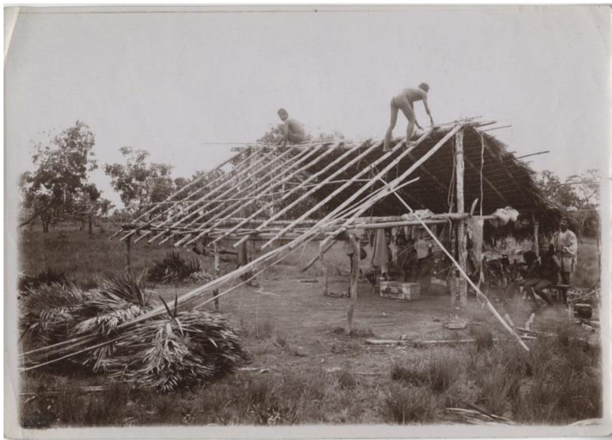
78. Construção de casa entre os Kayapó (1909).
