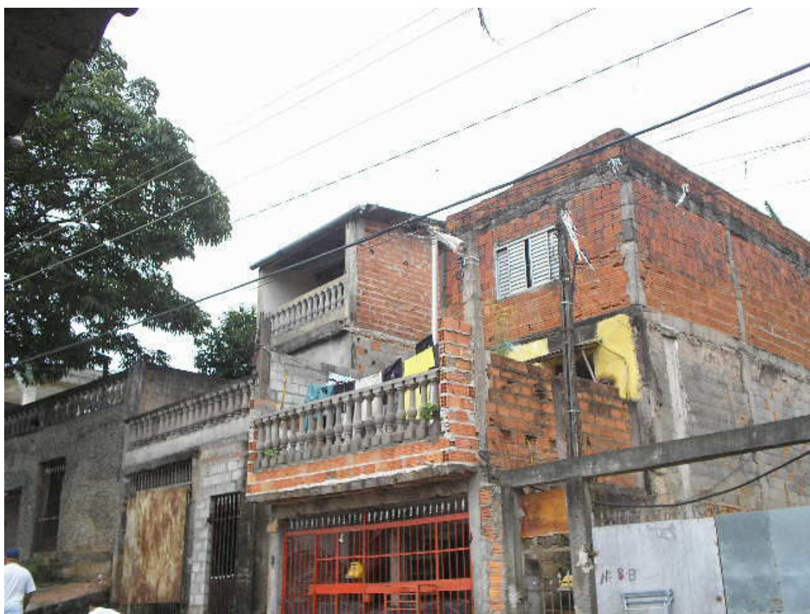
Fig. 4. Dois exemplos de casas auto-construídas . À esquerda, em fase de finalização; à direita, o início da construção.
