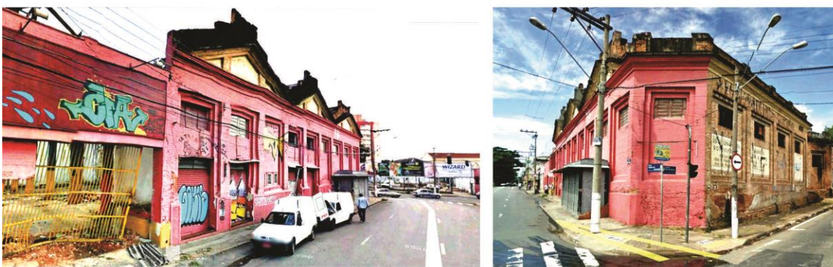
Imagem 09 - Antigo Galpão Comercial - R. Barão de Parnaíba (demolidos) fonte da imagem: Google StreetView, 2012. Imagem tratada pela autora, 2015
