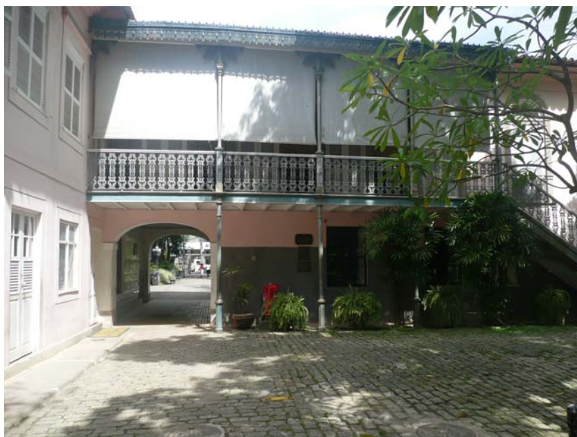
Fig.162. Sacada interna da residência, 2009.
