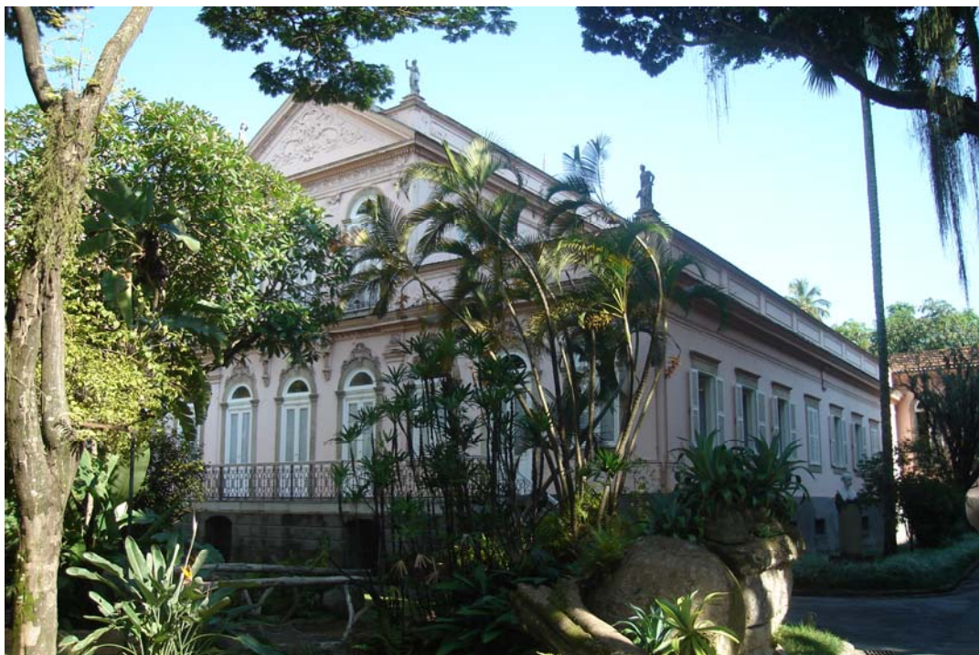
Fig.49. Fachada da Casa Museu Rui Barbosa, 2009.
