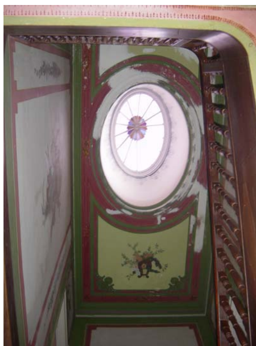
Fig.51. Clarabóia no Hall de acesso ao Sótão, 2009.
