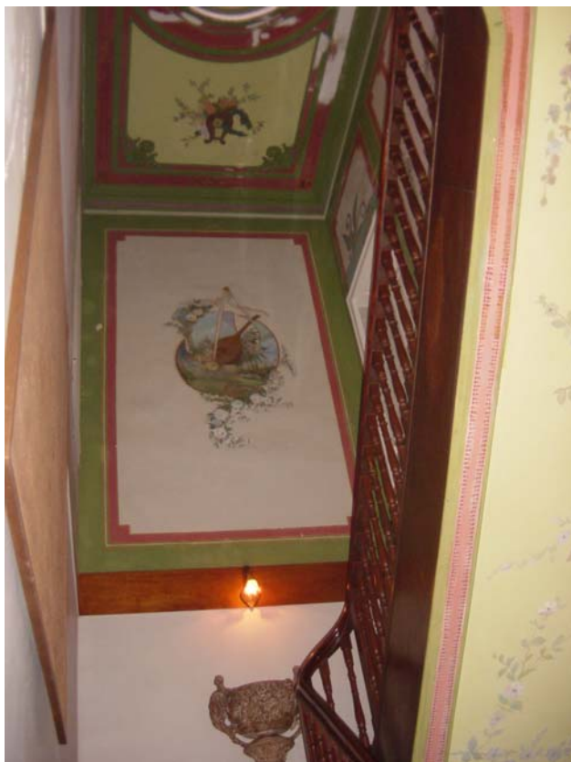
Fig.132. Escada de acesso ao sótão, 2009.
