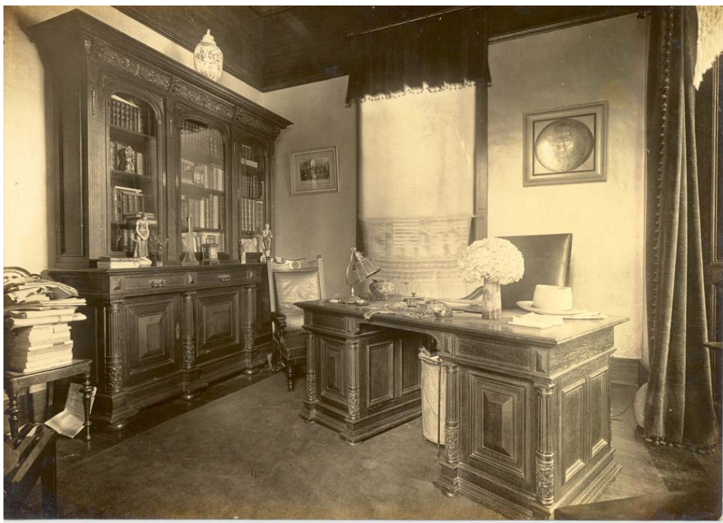
Fig.74. Gabinete holandês, em Petrópolis, c.1923
