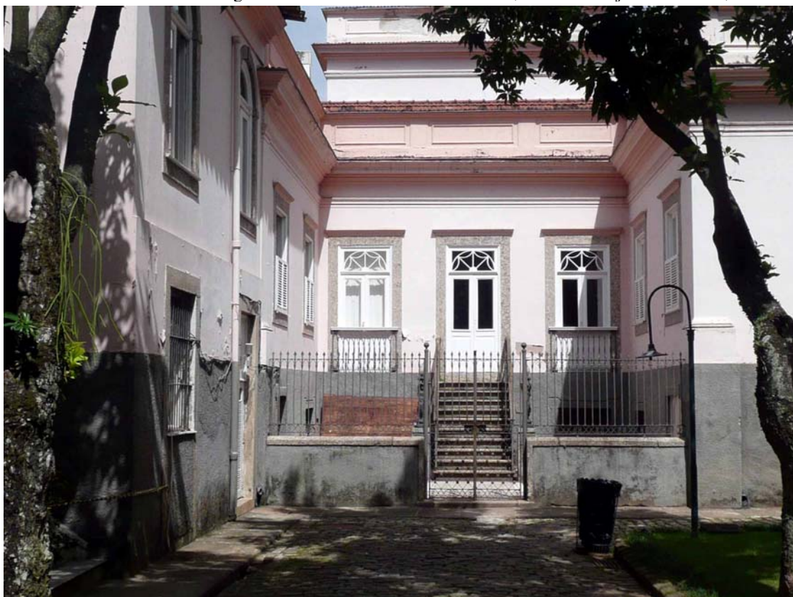
Fig.115. Porta de entrada da Biblioteca, vindo-se do jardim interno, 2009.
