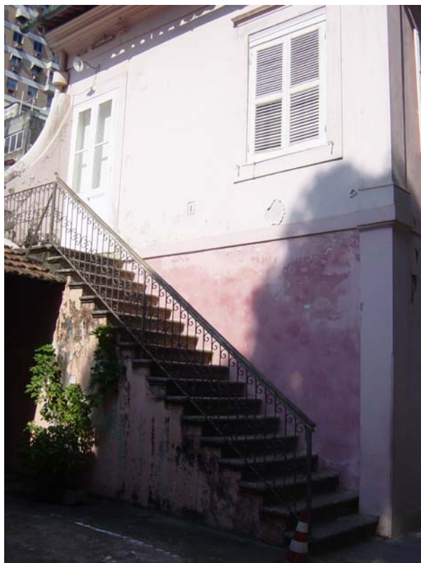
Fig. 177. Escada de acesso ao Corredor de serviço, 2009.
