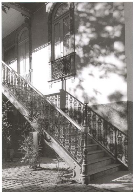
Fig. 160. Escada de acesso a sacada interna, 1999
