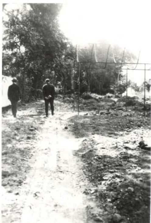
Fig.44. Obras para restauração do jardim lateral
