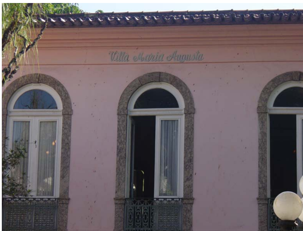
Fig. 61. Fachada onde está incrustada na alvenaria Vila Maria Augusta, 2009
