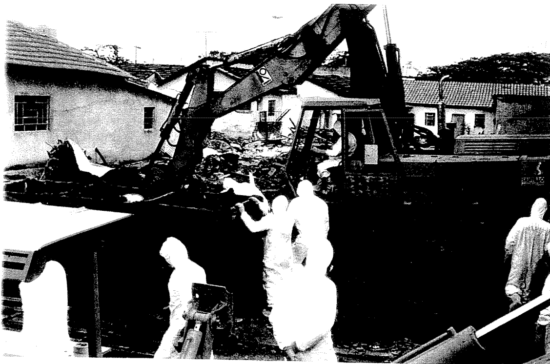
Demolição das casas do lote de Roberto Santos Alves à Rua 57 N° 68, Setor Central.
