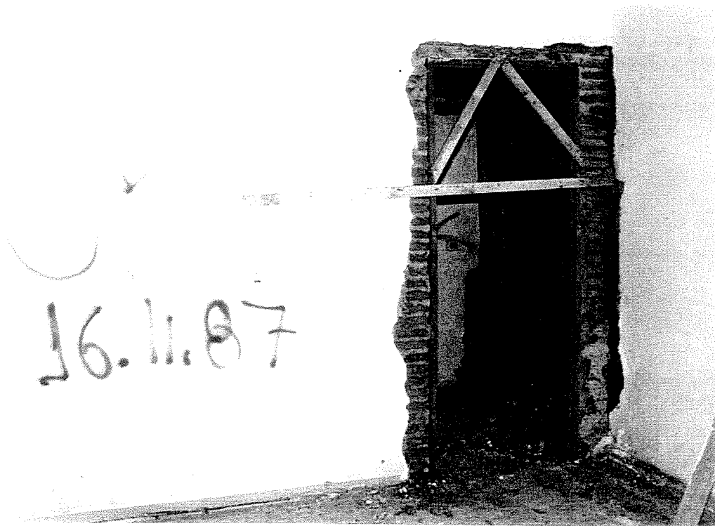
Processo de descontaminação de interiores. Casa de Wagner Mota. Remoção de piso e reboco contaminados.
