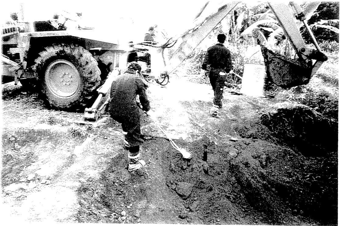
Descontaminação de terreno.
