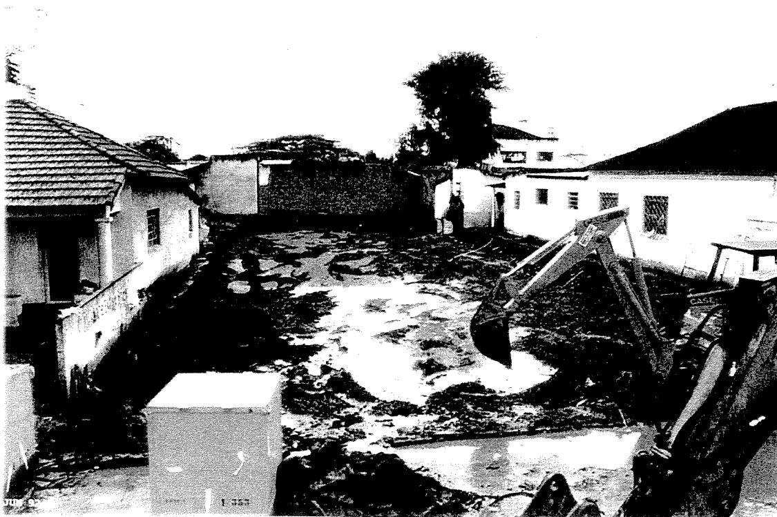
Lote da Rua 57 N° 68, Setor Central, após a demolição das quatro casas.
