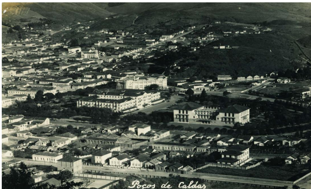
Figura 19: O novo espaço balneário do Brasil. Vê-se ao fundo as Thermas Antônio Carlos, à esquerda o Palace Hotel e à direita o Palace Casino. Data: 1933 Acervo: Museu Histórico e Geográfico de Poços de Caldas
