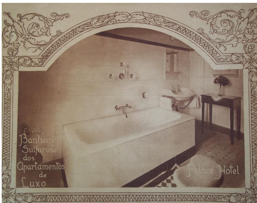
Figura 30: Banheiro Sulfuroso dos apartamentos de luxo do Palace Hotel. Imagem localizada no primeiro álbum de propagandas da Companhia Brasil de Grandes Hotéis. 1931
