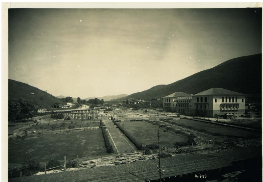
Figura 14: Execução paisagística do Parque José Afonso Junqueira vendo-se à direita o Palace Casino e à esquerda a construção da pérgola. Data: 16/09/1929.
