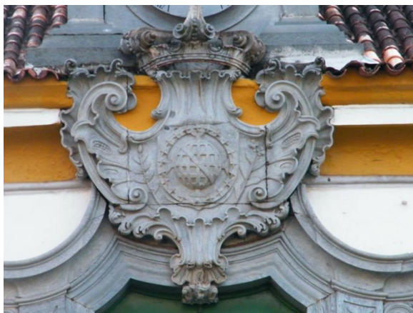
Figura 65– Elemento da fachada da Câmara Municipal de Mariana. Construção iniciada na segunda metade do séc. XVIII.
