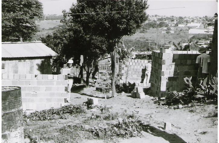
**Imagem 46.** Obras de urbanização. Construção das “unidades sanitárias”. Observe-se a proximidade entre elas. 1989/1990.
