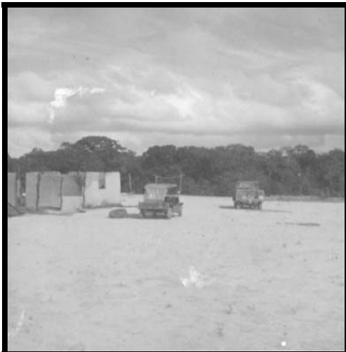
Foto 14 – Fazenda Muriru, destruída pela GDF
