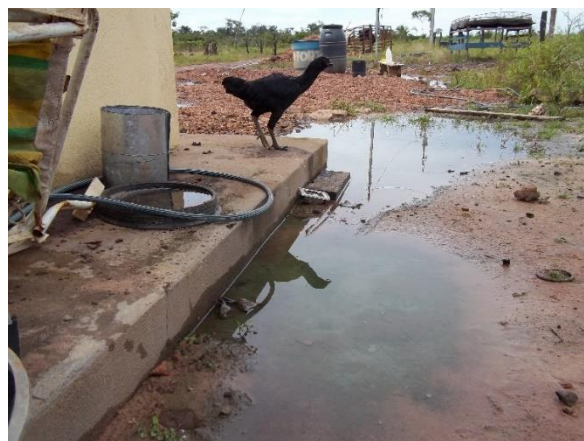
Figura 25: Água acumulada no entorno das casas Fonte: Ministério Público Federal - TO
