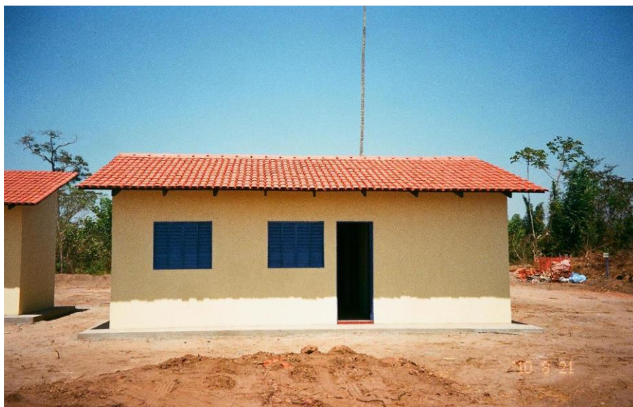
FIGURA 10: Fachada principal da casa. Lote 50, agosto de 2010
