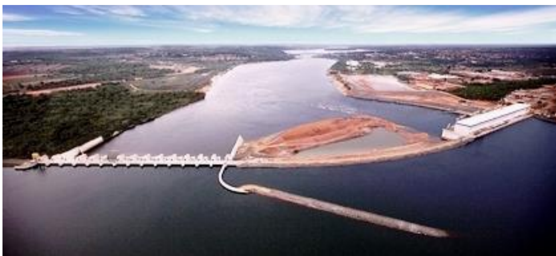
FIGURA 1: Vista aérea da UHE Estreito (desde sua montante; à esquerda, Tocantins, à direita, Maranhão) Fonte: OAS Engenharia 9
