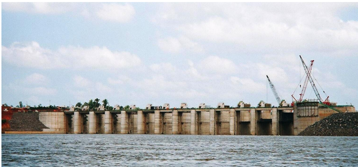
FIGURA 5. Usina Hidrelétrica Estreito, na última fase de sua construção, vista de sua montante em janeiro de 2010
