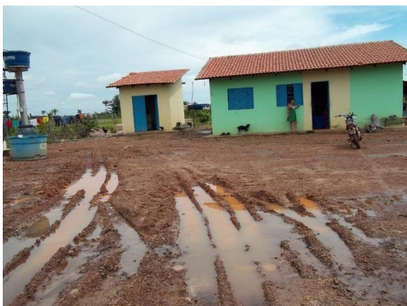
Figura 24: Entrada principal da residência Fonte: Ministério Público Federal - TO
