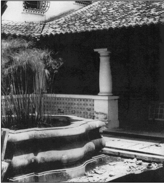
Figura 20. Pátio do Solar. Década de 1920. As colunas toscanas, alpendre e azulejos. Fonte: BANDEIRA, 2008
