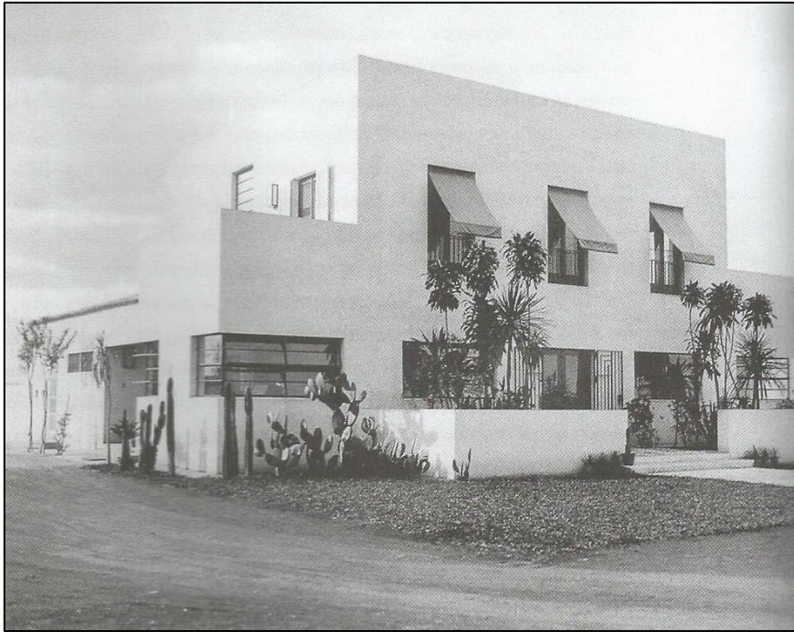
Figura 33. Casa da Rua Santa Cruz. Foto de Hugo Zanella. 1927. Arquiteto: Gregori Warchavchik. Fonte: LIRA, 2011.
