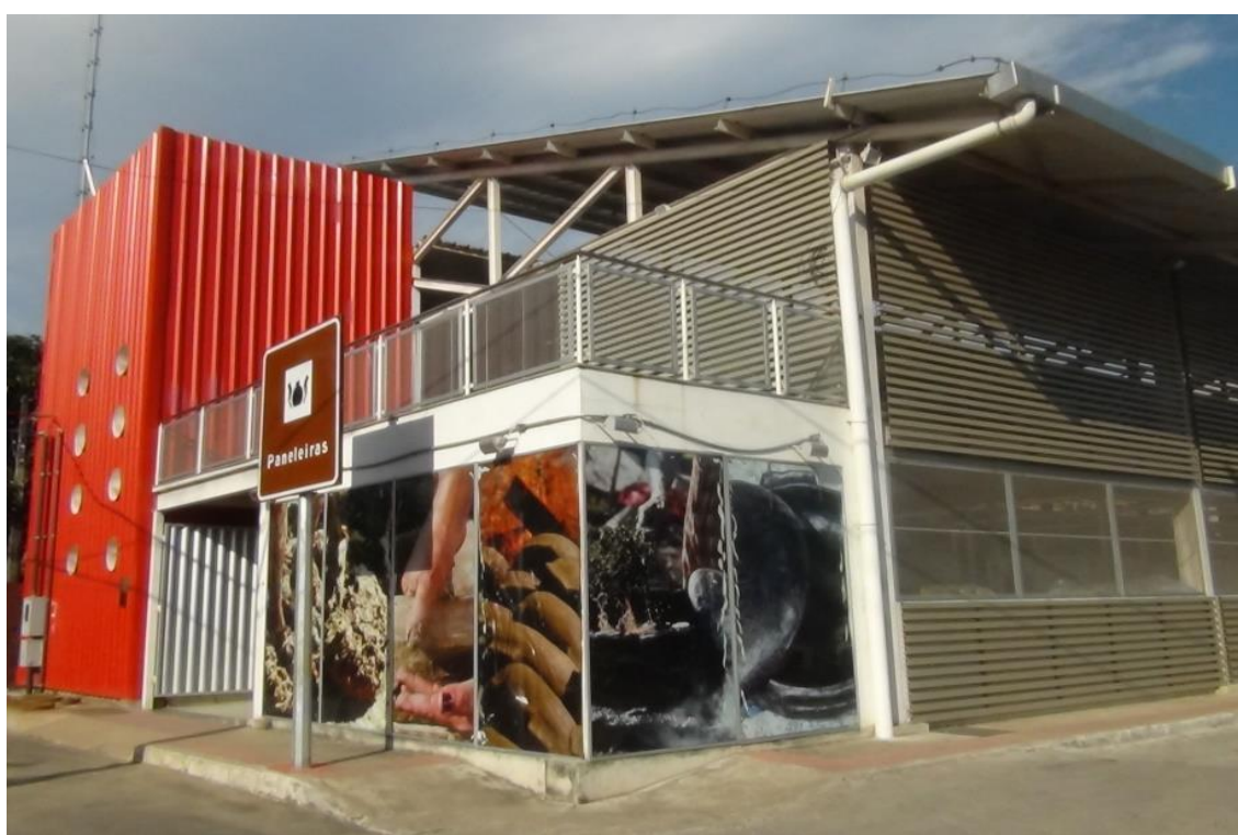
Figura 4: Galpão das Panelas em 2013.
