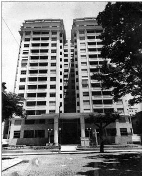
Figura 1: Edifício Getúlio Vargas, IAPB. Praça São Salvador, Rio de Janeiro, década de 1950.
