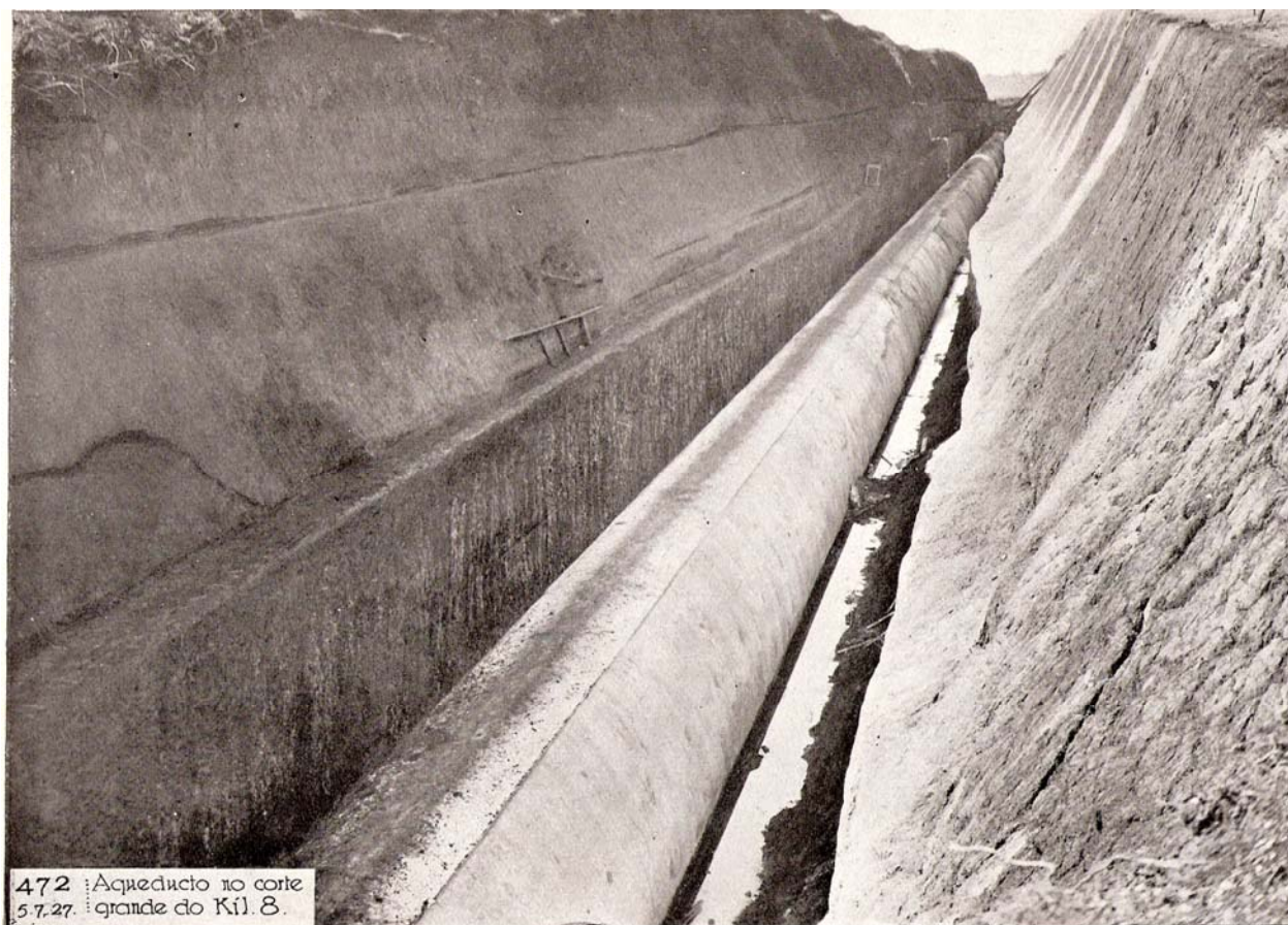
Implantação do sistema de aqueduto no “corte grande do Kil. 8” para a adução do Rio Claro. Levantamento fotográfico do próprio Relatório da Comissão de Obras Novas de Abastecimento de Água da Capital. Acervo Particular do Autor.
