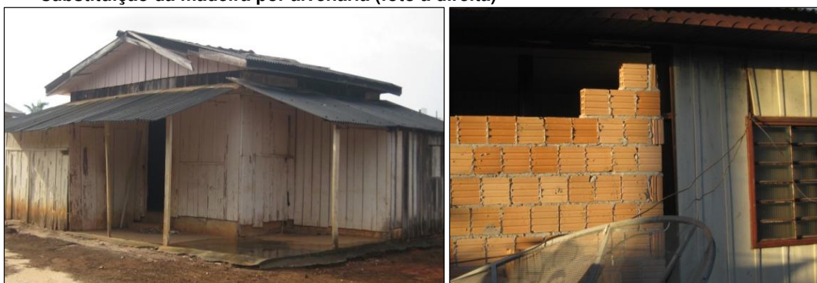
Figuras 21 e 22 – Casa de madeira no estilo das primeiras ocupações (foto a esquerda) e substituição da madeira por alvenaria (foto a direita)
