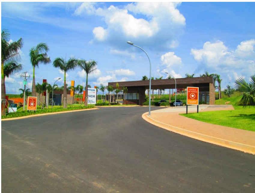
Figura 12 - Portaria Loteamento Pedra Alta
