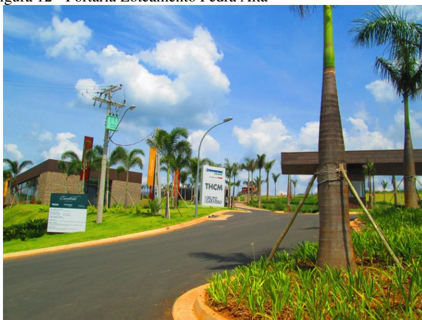
Figura 13 - Portaria Loteamento Pedra Alta
