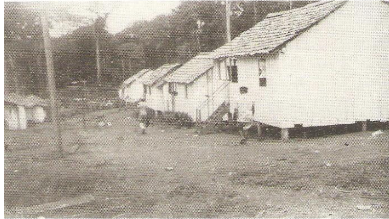
Figura nº 6 – As casas construídas pela ICOMI em Serra do Navio eram erguidas sobre estacas para evitar a umidade do solo e estavam de 8 a 10 metros acima do leito do rio. Fonte: GUERRA, Antônio Teixeira. Op. cit. , p. 226.
