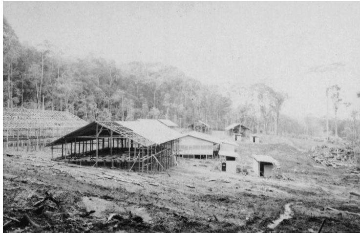
Figura nº 4 – Início das obras em Serra do Navio. Foto: Tibor Jablonsky.
