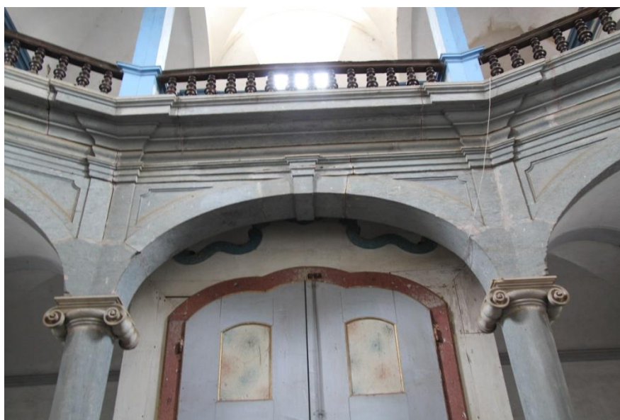
Figura 42 - Divisão do suporte do coro em três arcos (detalhe). Fonte: Acervo da autora, 2014.
