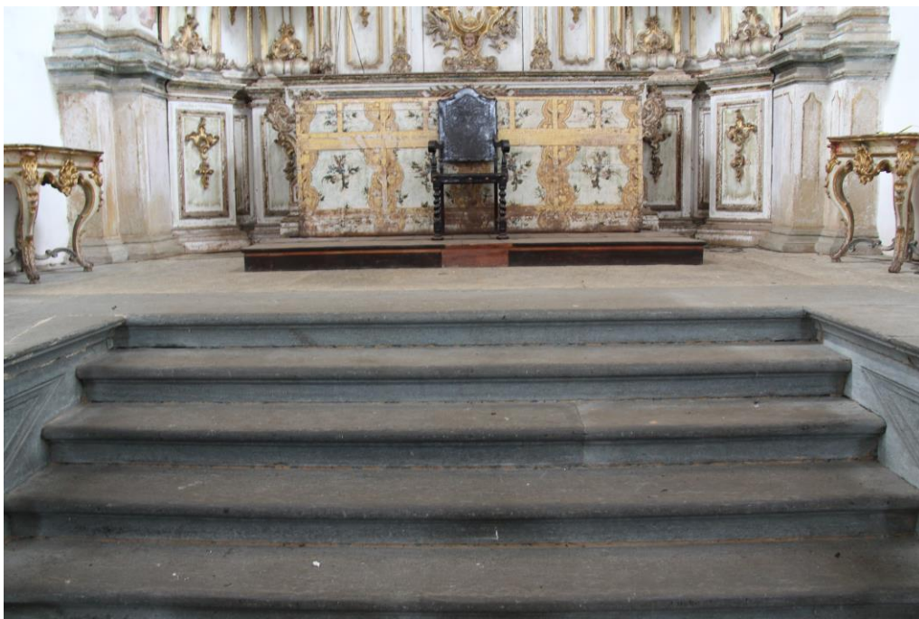
Figura 55 - Escadaria em pedra na capela-mor. Fonte: Acervo da autora, 2014.
