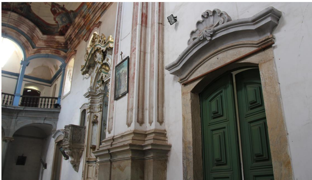
Figura 12 - Vista interna da Capela (lado do Evangelho) e portal de pedra em destaque. Fonte: acervo da autora, 2014.
