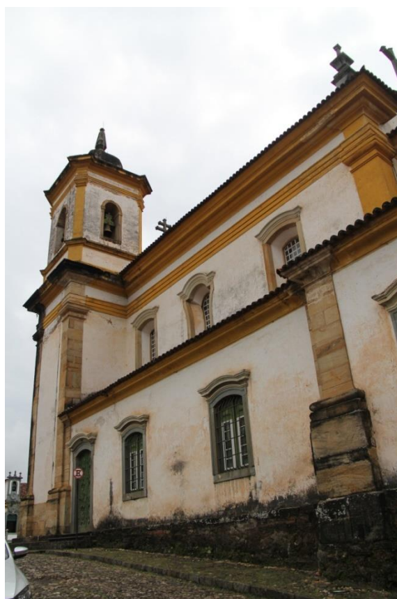
Figura 26 - Fachada lateral da Capela. Fonte: Acervo da autora, 2014.
