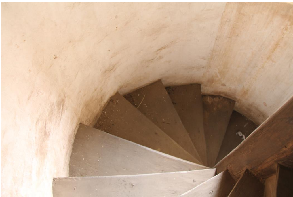
Figura 62 - Interior da torre, escada de acesso. Fonte: Acervo da autora, 2014.
