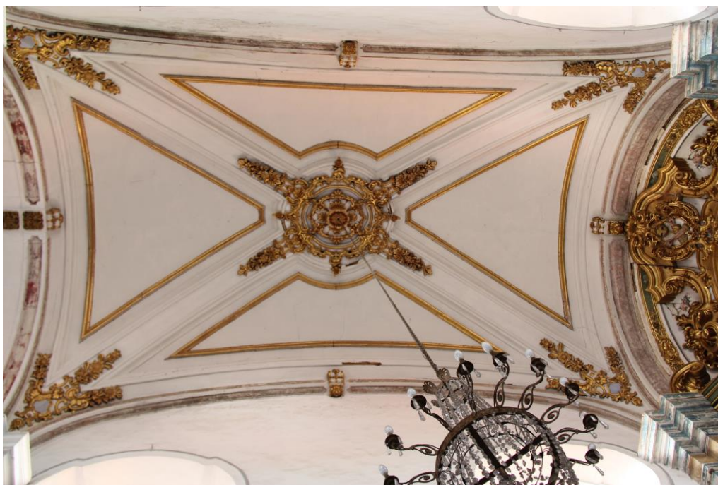
Figura 56 - Forro da capela-mor. Fonte: Acervo da autora, 2014.
