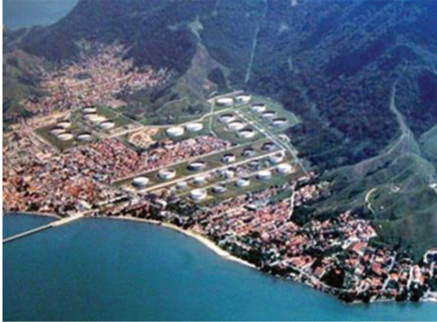
FIGURA 14 - Área urbana central de São Sebastião e tanques do TEBAR, 2010
