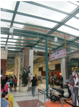
▲ Fig. 246 (várias). Cobertura metálica como elemento conector das duas alas da antiga fábrica, acessado pelo corredor onde encontram-se a Chaminé e a torre do relógio. Fotos: E.D-K.
