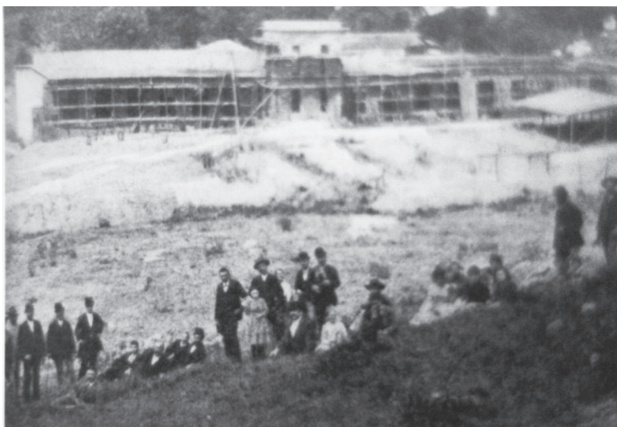
► Fig.141. Fábrica em construção. Enrico Dell’Acqua está no grupo central de pessoas, à esquerda, sem chapéu. Fonte: Colombo, 1999, pg. 58.
