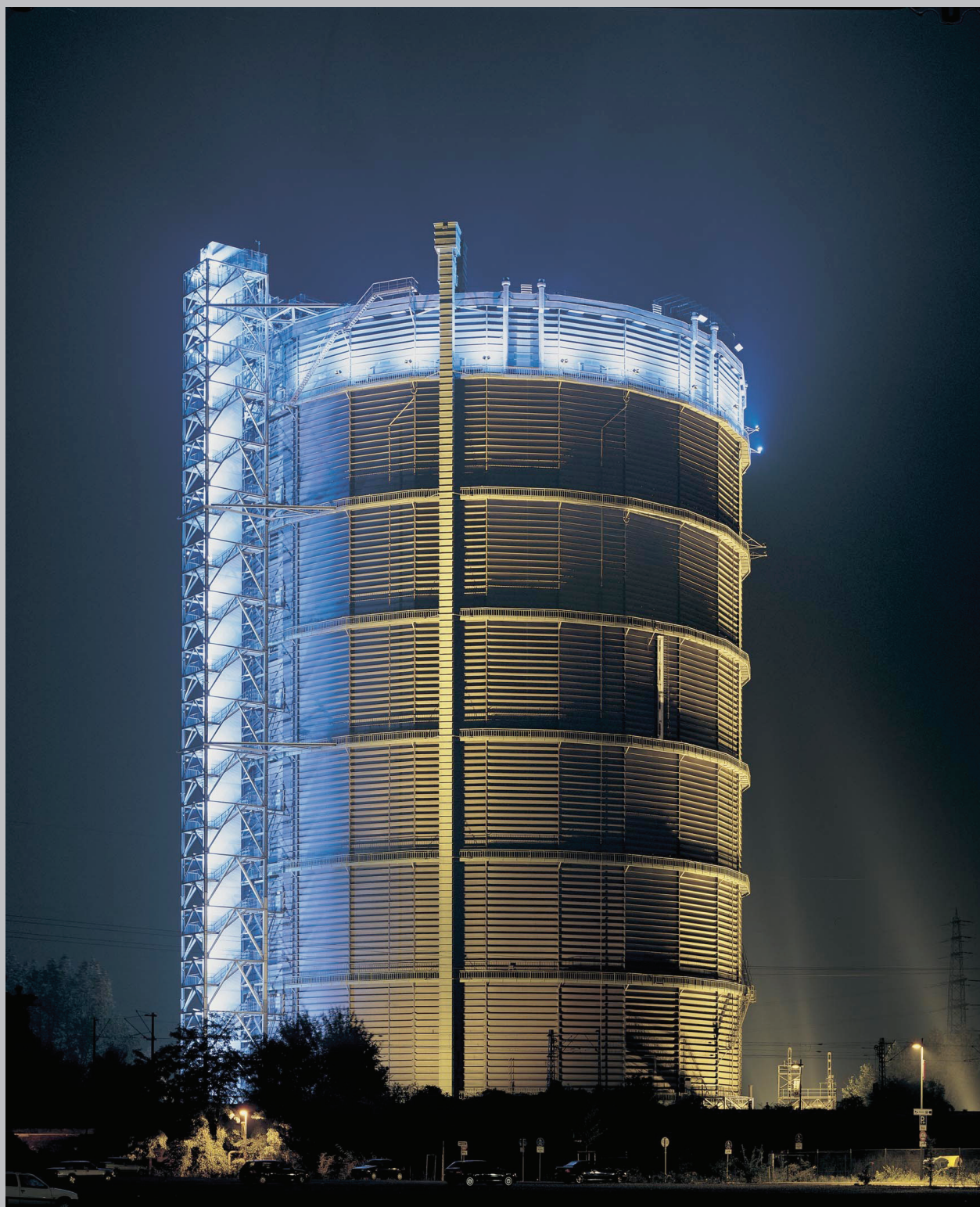
▲ Fig. 69. Gasômetro de Oberhausen, Vale do Ruhr, Alemanha. Este foi o maior depósito de gás da Europa. Foto: Karola Kohler. Disponível em: < http://www.dlr.de/rd/Portaldata/1/Resouces/portal_news/newsarchiv2007/gasometer_380.jpg >. Acesso em 22 mar. 2010.
