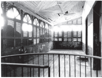
▲ Fig. 88. Fábrica de Tecidos Santa Amélia. Interior. Detalhe: varanda. Fonte: IPHAN, regional Maranhão.
