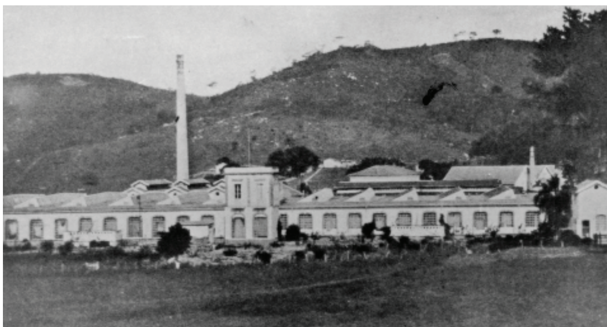
▼ Fig. 142. Vista panorâmica da Fábrica na década de 1940 do século XX. Fonte: Foto Studio Roque Jr.
