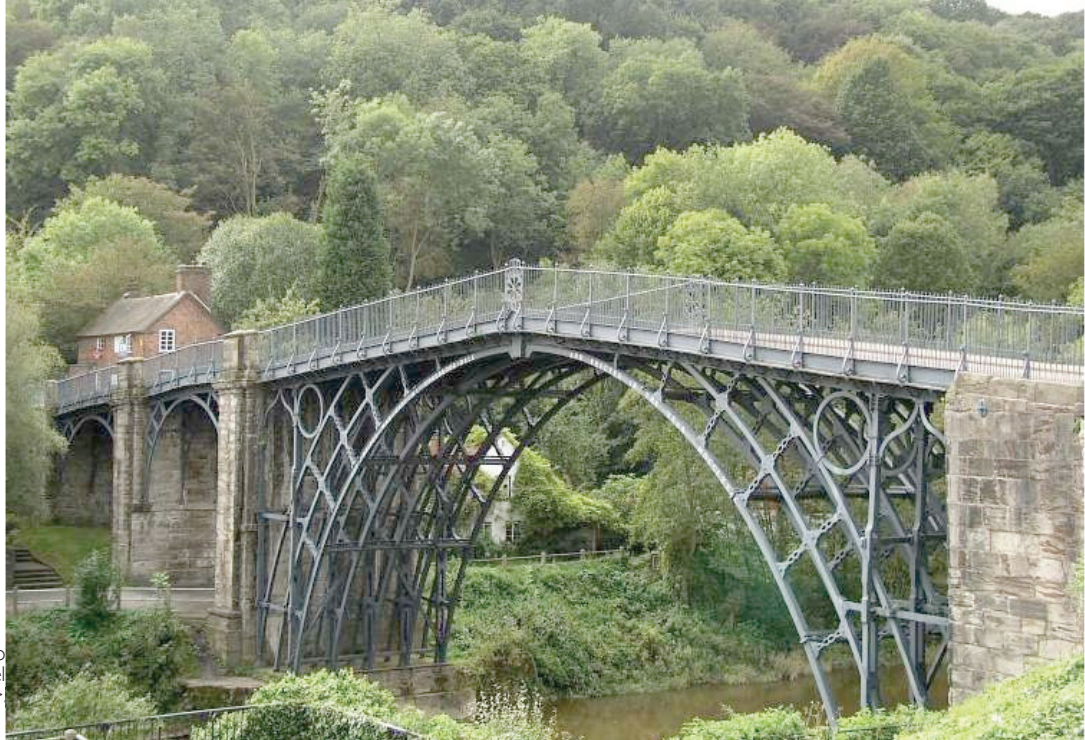
► Fig. 40. Ponte de ferro sobre o Rio Severn, 1775-1779. Disponível em: < http://www.ironbridge.org.uk > Acesso em: 18 jul. 2009.
