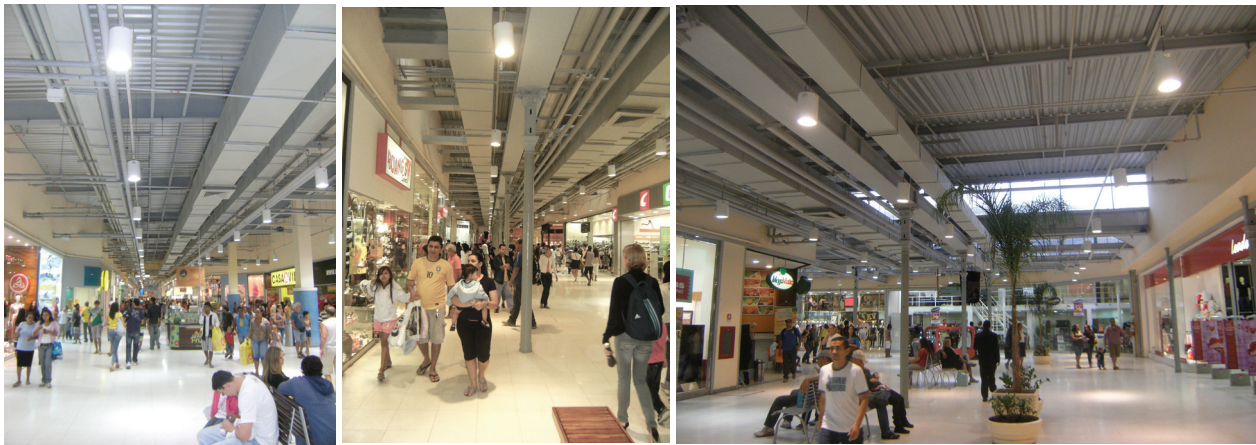
▲ Fig. 244 (várias). Espaços internos do Shopping, onde observam-se as colunas metálicas, shed e cobertura da Fábrica Bangu. Fotos: E.D-K.
