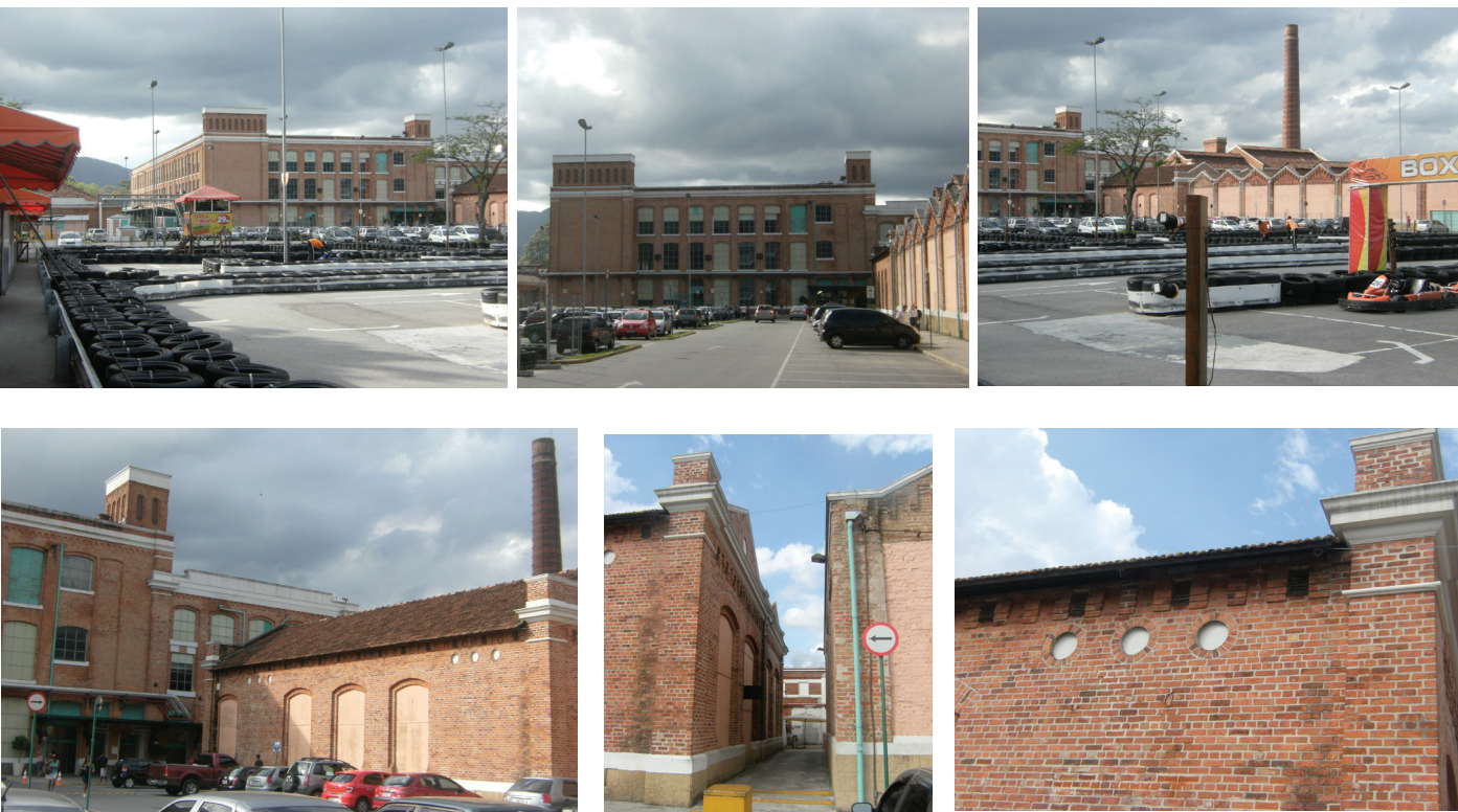
▼ Fig. 239. Vistas da Fachada, e seus detalhes, da Fábrica Bangu junto à Rua da Feira. Fotos: E.D-K.
