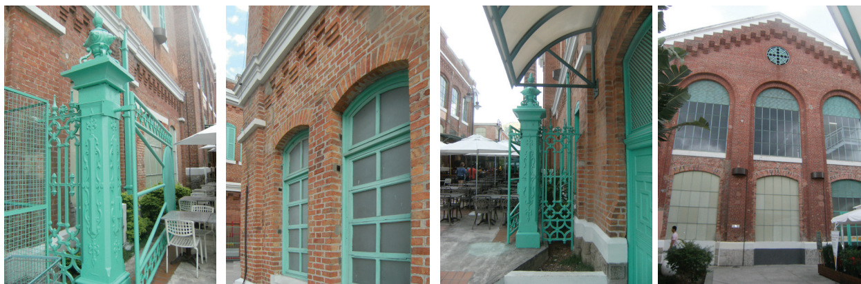
▲ Fig. 243 (várias). Detalhes de elementos do corredor de acesso principal à Fábrica Bangu. Fotos: E.D-K.
