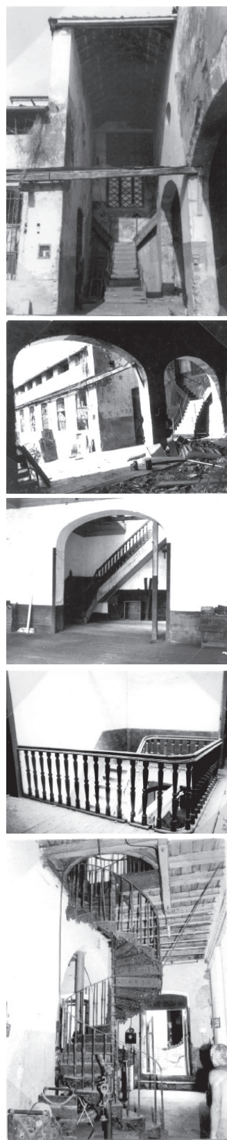
▲ Fig. 90. Fábrica de Tecidos Santa Amélia. Acesso ao pátio externo (a) e (b); escada de madeira (c) e (d); escada de ferro (e). Fonte: IPHAN, regional Maranhão.
