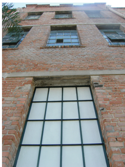
►▼▼ Fig. 221. Cia Nova América, detalhes dos espaços internos. (a) shed; (b) alvenaria de tijolo aparente; (c) sistemas elétricos e de iluminação parcialmente aparentes; (d) estrutura aparente; (e) Cenários para caracterização da Rua do Rio; (f) preservação dos espaços originais fragmentados, articulando-os através de passagens abertas, e por vezes cobertas. Fotos: E.D-K.
