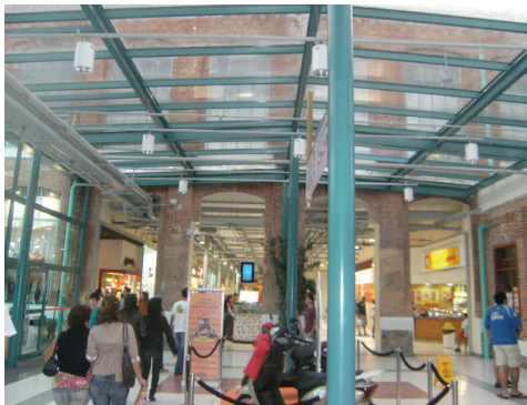
▲ Fig. 246 (várias). Cobertura metálica como elemento conector das duas alas da antiga fábrica, acessado pelo corredor onde encontram-se a Chaminé e a torre do relógio. Fotos: E.D-K.
