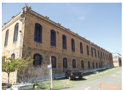
BLOCO K (DEPÓSITO DA EXPEDIÇÃO DE FIOS), VISTA DE FUNDOS, JUNTO AO RIO TIETÊ. ÁREA = 3.958,03m 2
