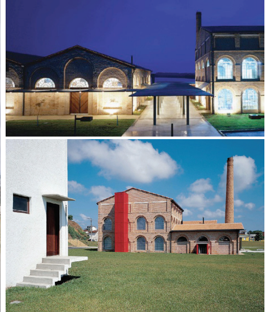
Fig. 78 Conjunto Industrial KKKK, Registro, São Paulo. Fonte: Caldeira; Fanucci; Ferraz; Santos, 2005. (a) vista noturna; (b) complexo fabril e as adaptações para o novo uso (em vermelho); (c) vista do conjunto fabril, da edificação nova e sua relação com o Rio Ribeira de Iguape num projeto mais amplo, o Parque Beira-Rio.
