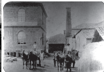
▼ Fig. 172. A Fábrica Júpiter foi construída junto a queda do Rio Tietê e trouxe para a região uma inovação tecnológica do século XIX, a turbina hidráulica. As máquinas foram adquiridas da Platt Brothers & Co. Limited, de Oldham, Inglaterra. Fonte: Museu da Cidade de Salto.
