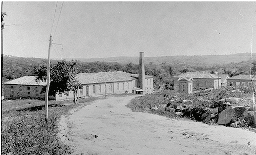
◀ Fig. 171. Fábrica Júpiter. A Rua central é a antiga Rua do Porto, que em 1910 será incorporada pela fábrica que sucedeu a Júpiter, eliminando esta ligação da população com o Rio Tietê. Fonte: Museu da Cidade de Salto.
