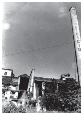
▲ Fig.82. Cotonifício Cândido Ribeiro - Fábrica de Tecidos Santa Amélia. Vista dos Fundos, Chaminé. Fonte: IPHAN-Regional Maranhão.
