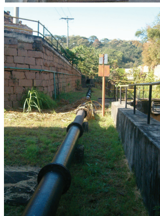
▲ Fig. 188. Remanescentes das tubulações de água para acionamento da turbina geradora de energia. Fotos: E.D-K.
