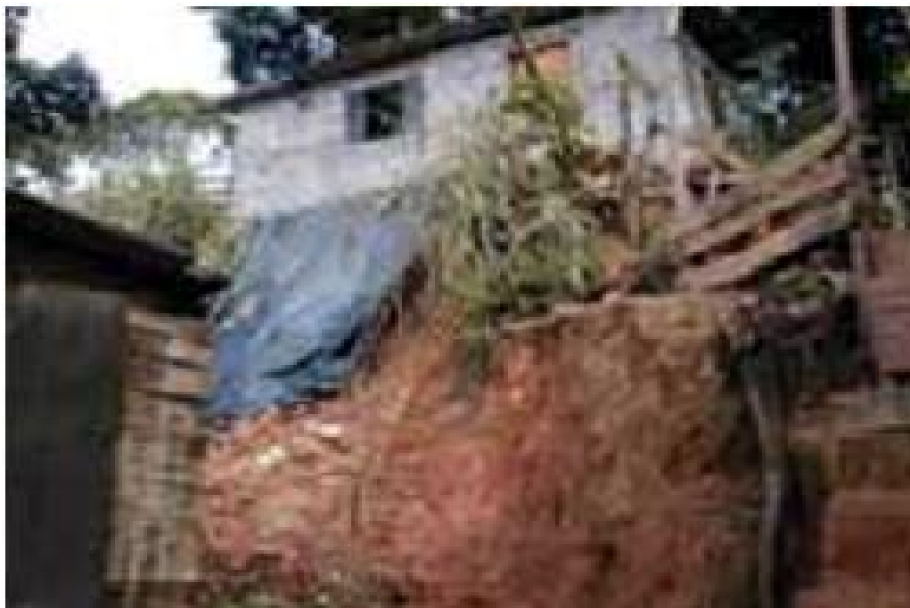
Figura 11 – Exemplo de estratégia de prevenção: encosta coberta com lona plástica para evitar infiltrações
