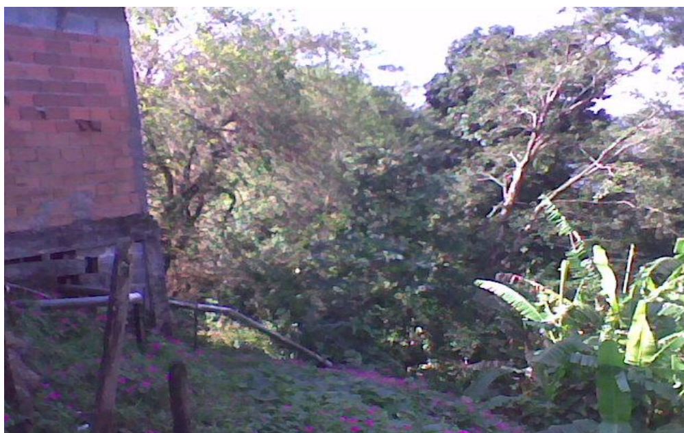
Figura 5 – Fator de risco de deslizamento: lançamento de efluentes em encosta
