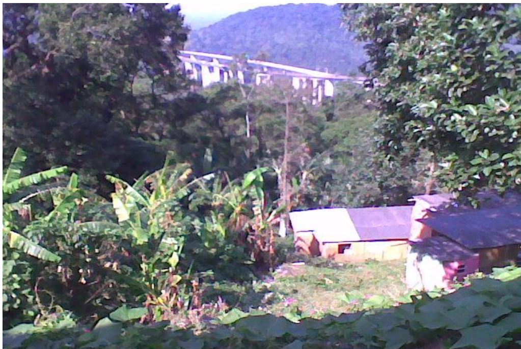
Figura 8 – Fator de risco de deslizamento: casas construídas em sistema de corte e aterro
